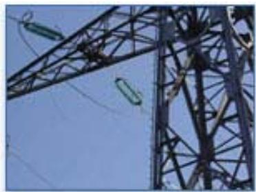
Les chaînes d'isolateurs, généralement en verre, assurent l'isolement électrique entre le pylône et le câble sous tension. Ils sont d'autant plus nombreux que la tension est élevée.
