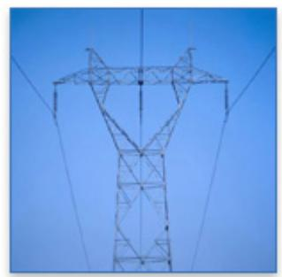
Le rôle des pylônes est de maintenir les câbles à une distance minimale de sécurité du sol et des obstacles environnants, afin d'assurer la sécurité des personnes et des installations situées au voisinage des lignes.
